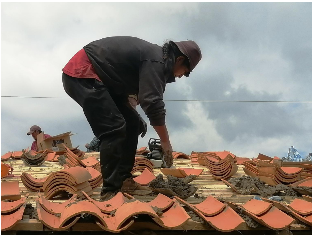
Figura 29: Colocado de las tejas, son fijadas con lodo.
