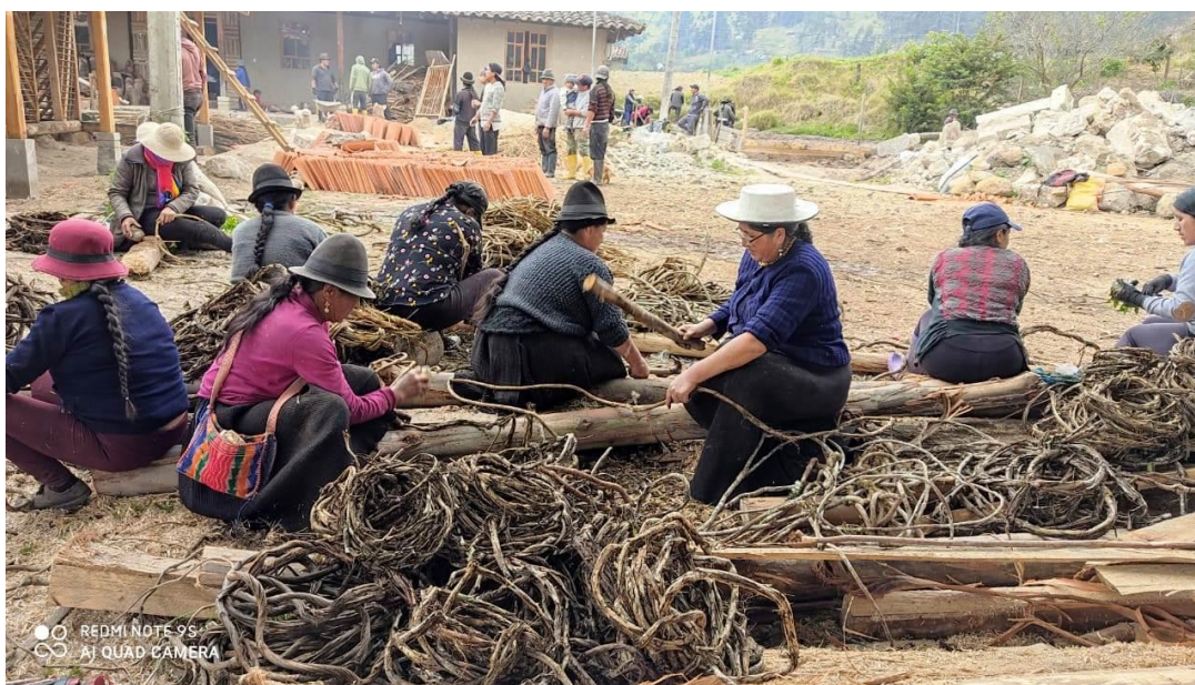
Figura 14: Minga, mujeres participando de la minga, ellas preparan bejuco para amarrar las chinchas en las paredes antes del embarre.
