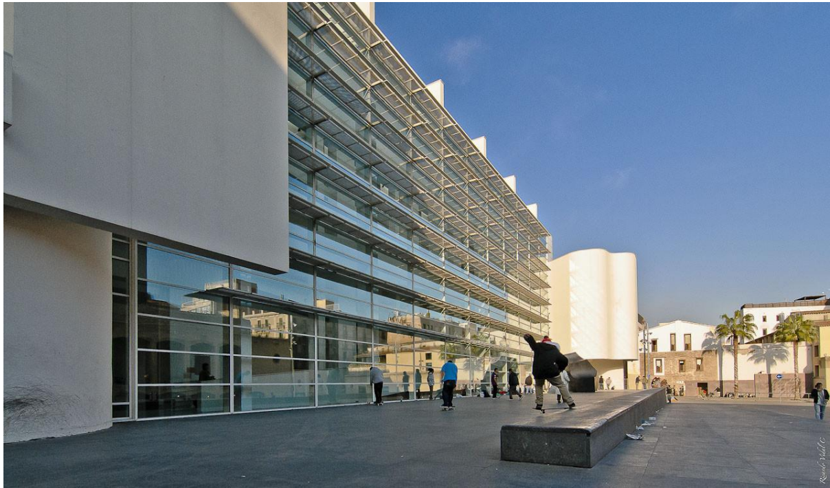
Figura 13. Fachada Museo Barcelona. Elaboración Plataforma Arquitectura
