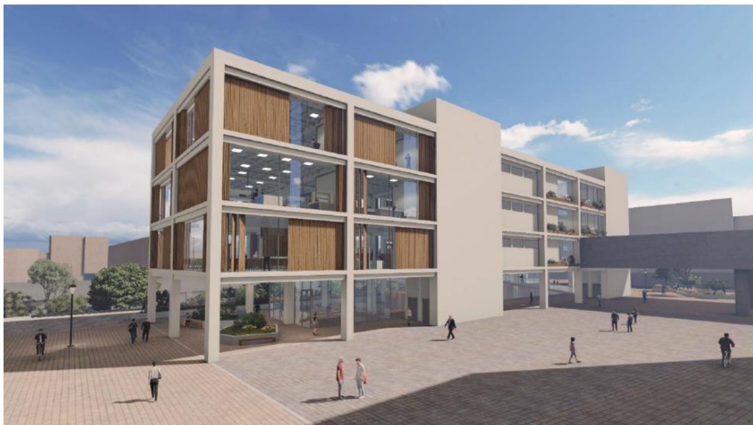
Figura 52. Vista fachada este. Elaboración propia.
