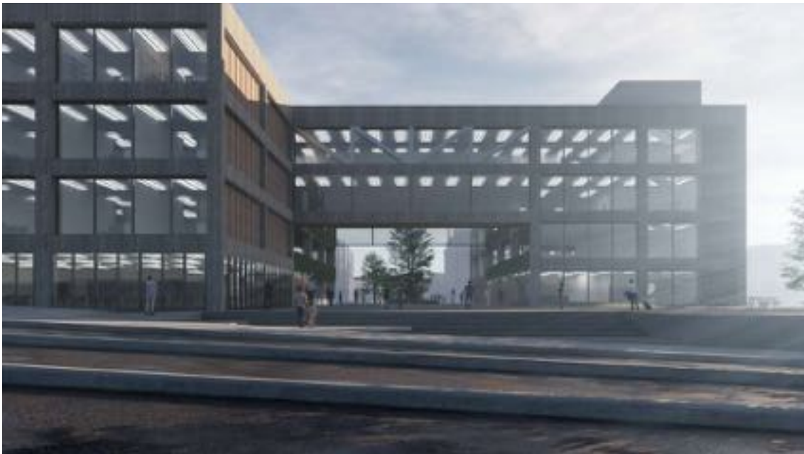
Figura 40. Vista edificio desde estación Rio Coca. Elaboración propia.
