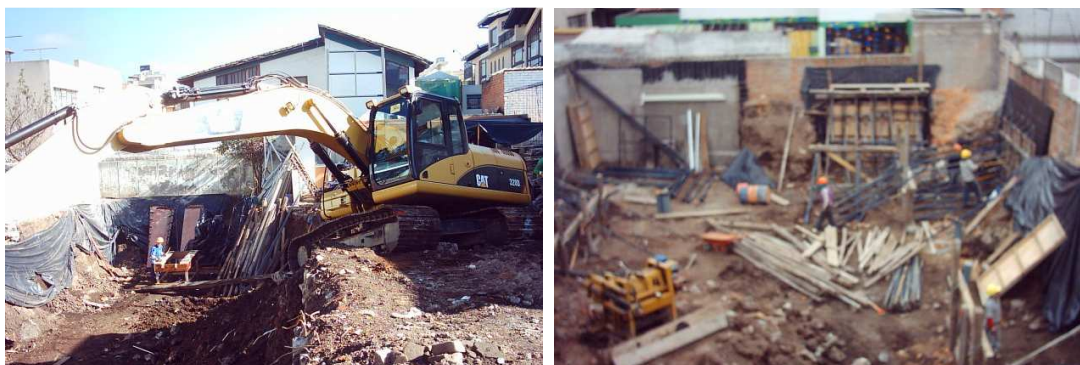
IMAGEN 4.11 Foto de Excavación
