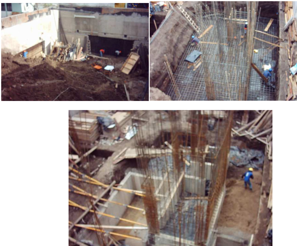
IMAGEN 4.12 Foto de Excavación
